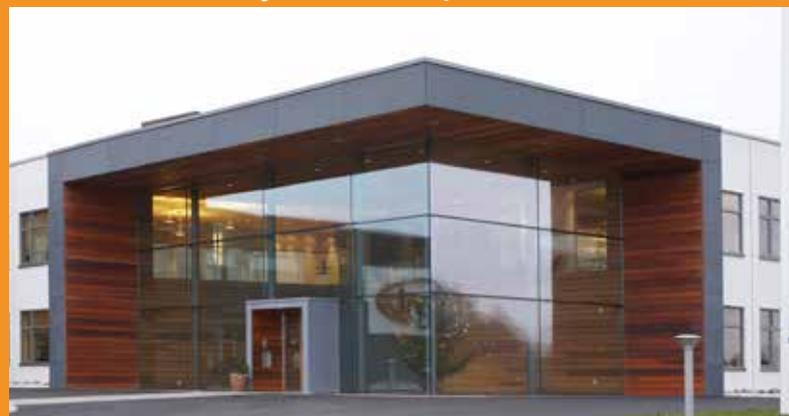
Каждое здание Bashallen® является уникальным – проектируется в соответствии с индивидуальными потребностями заказчика. При производстве внешней несущей стены в ней можно предусмотреть оконные, дверные, воротные проемы. Возможна различная отделка и цвет поверхности фасадов. Система Bashallen® позволит осуществить все Ваши задумки.
