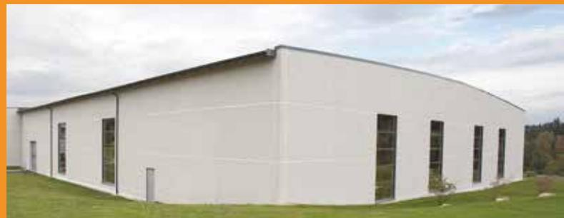
Свойство железобетонных конструкций поддерживать постоянную внутреннюю температуру позволяет снизить энергозатраты на отопление и кондиционирование здания. Количество дорогого вентиляционного оборудования может быть уменьшено, можно работать без воздушного кондиционирования или при незначительном уровне кондиционирования. Фасады прочные, поэтому эксплуатационные расходы на них не высоки. С течением времени стоимость зданий Bashallen® сохраняется на высоком уровне.
